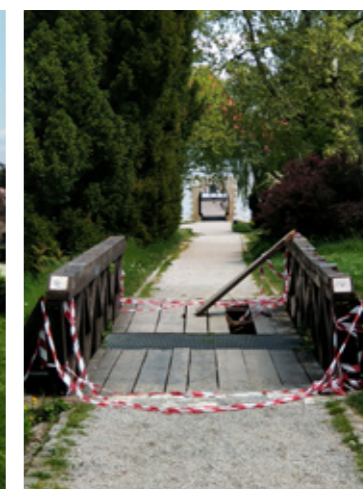
Pogled prema istoku na Kulu stražarnicu
